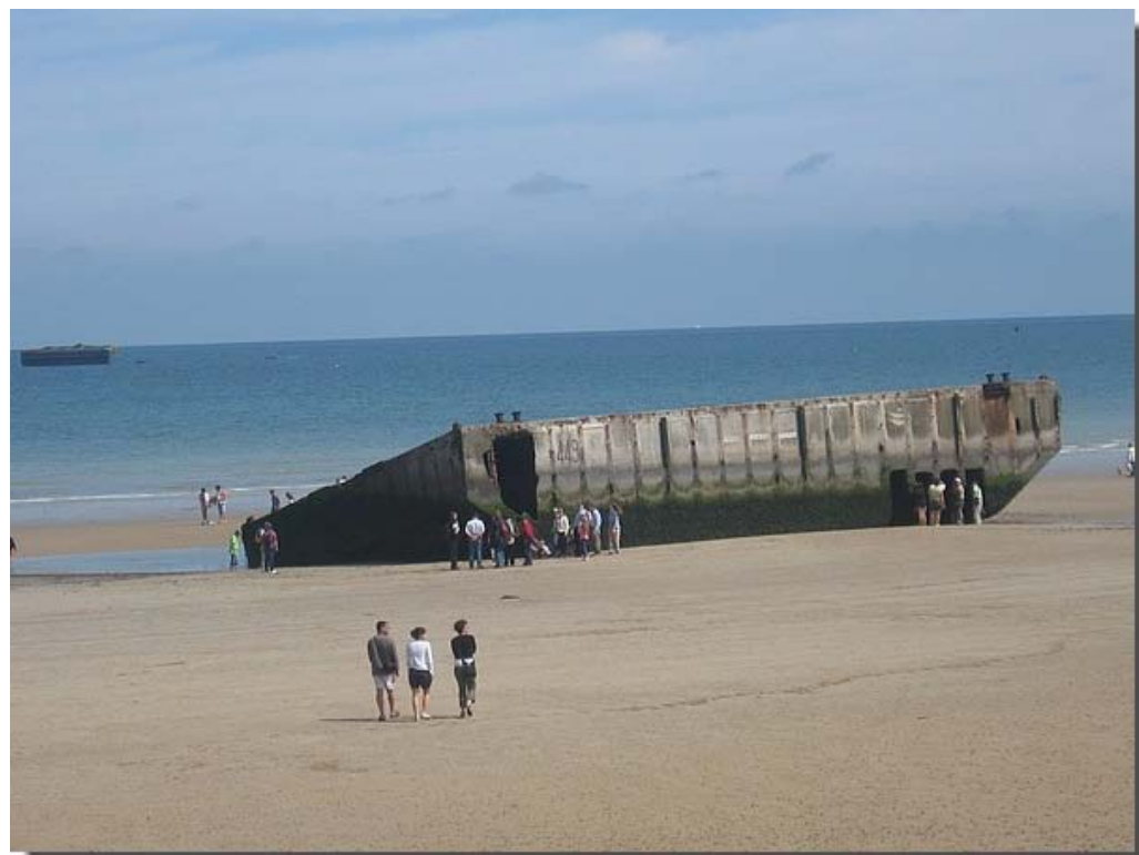
De pontons uit de oorlog, gemaakt van beton, die door de geallieerden werden gebruikt om er een brug naar het strand van te maken.
