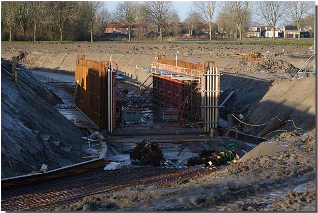
Aanleg fietstunnel Dyksterhuzen
