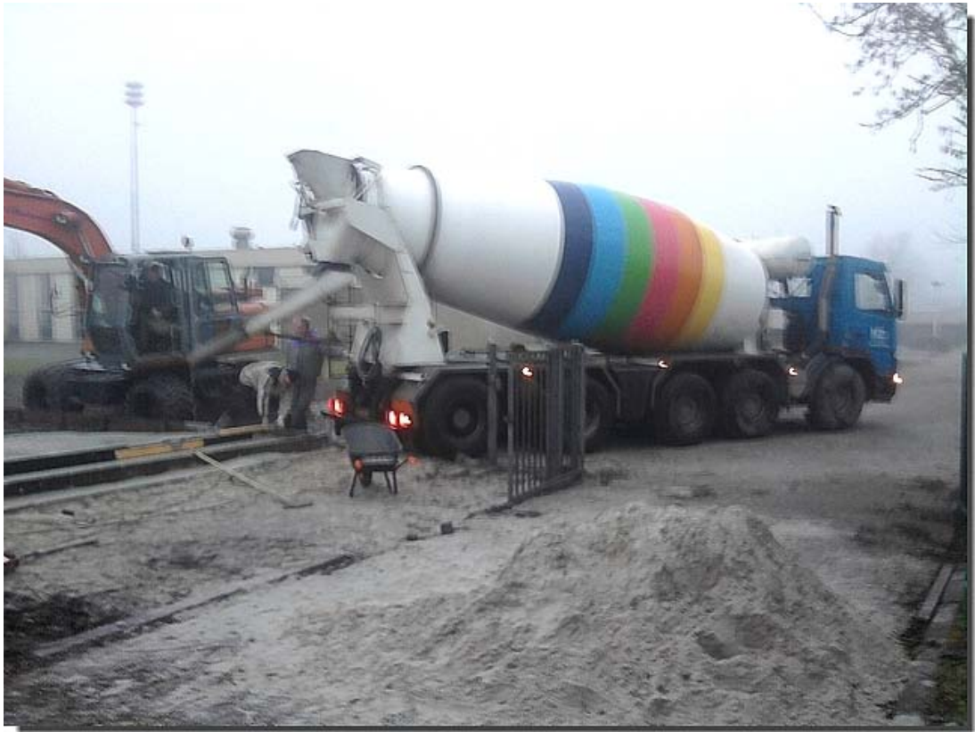
Met behulp van een kraan werd het beton gestort.
