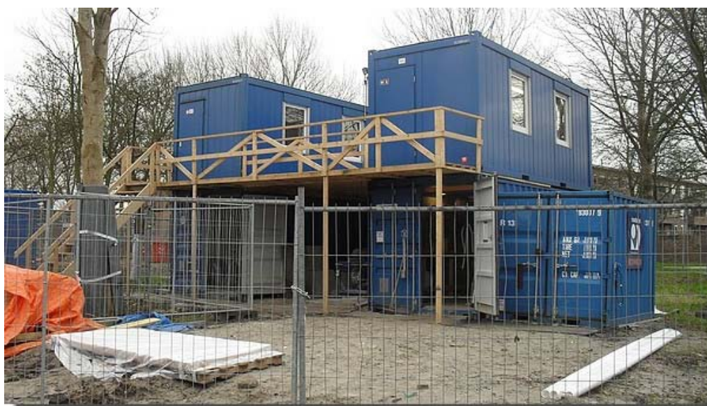
De containers, uitvoerders- en schaftkeet
