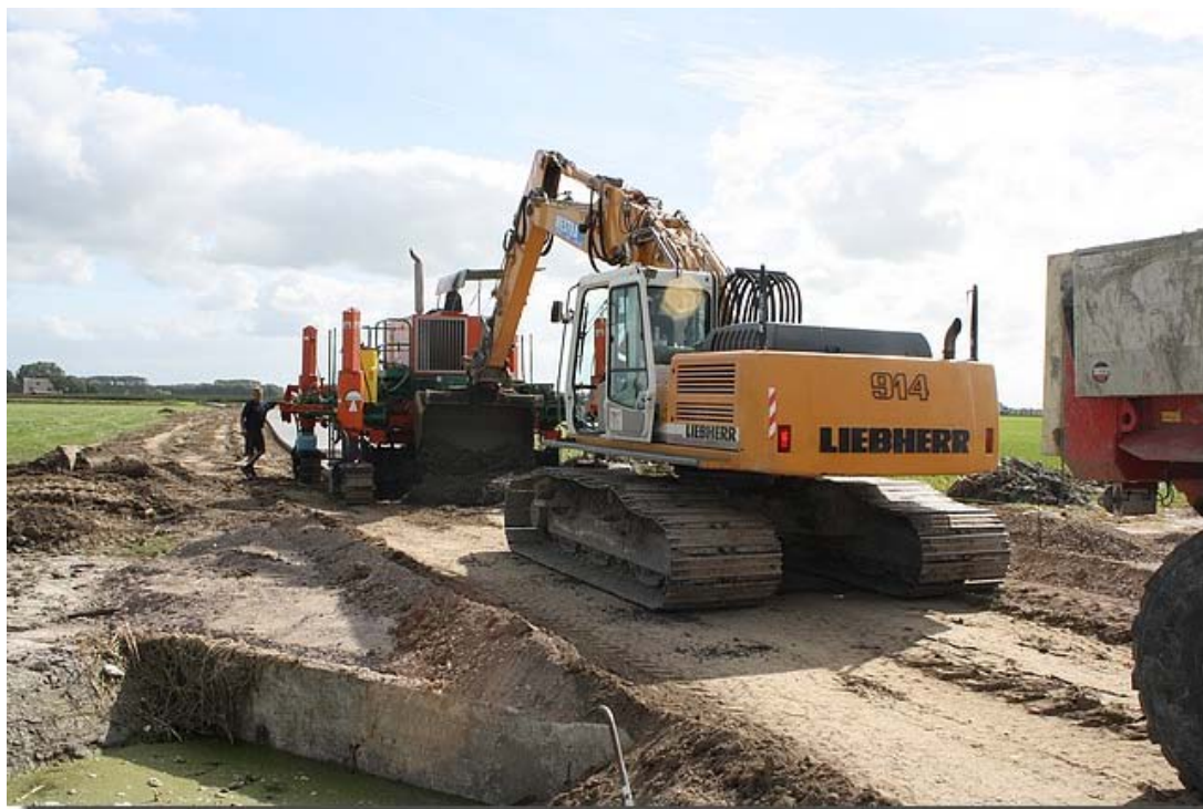
Met een kraan werd het verse beton voor de machine gelegd.
