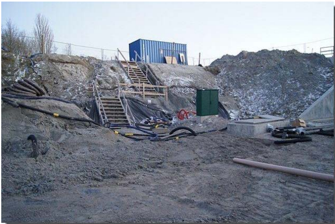
Ook de werkzaamheden onder het viaduct gaan weer door.
