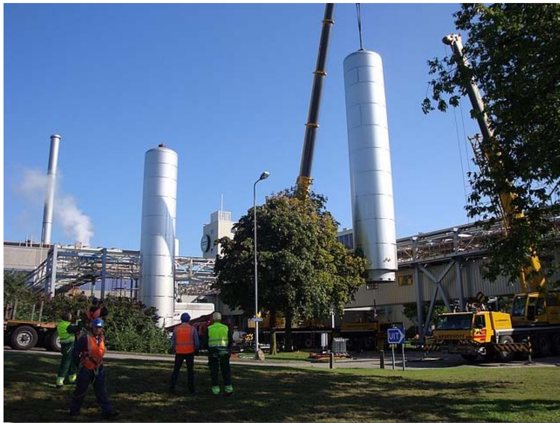
Hierboven : Plaatsen van 2 stuks nieuwe CO2 opslag tanks voor een bekende bierbrouwerij. Gewicht ca 45 tonper
