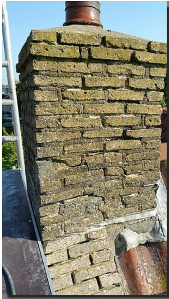
Dit is hem, je ziet dat hij bijna los op het dak staat.
